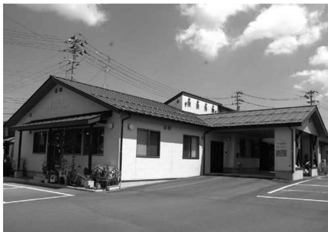
定員25人の小規模多機能「るびなす」にはデイサービスセンターが併設されている
